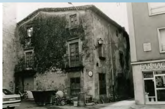
Obres de rehabilitació de l'edifici de Can Rosés, aproximadament 1995 (Ajuntament de Palafrugell)
