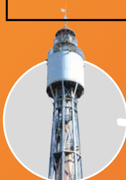
Dipòsit d'Aigua Modernista de Can Mario
