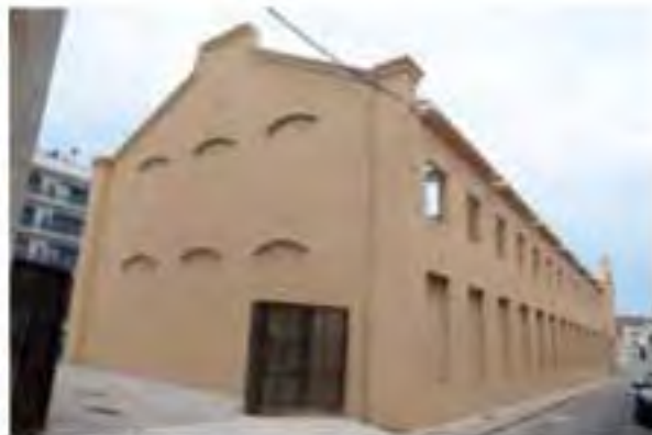
L'edifici de la Bòbila Vella, després de la remodelació. PACO DALMAU
