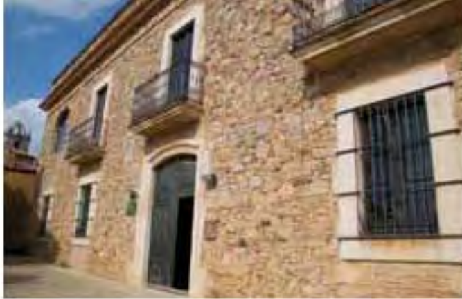
Façana de la casa dels Bassa Rocas a Llofriu, seu del Centre Cultural i Social. PURI ABARCA
