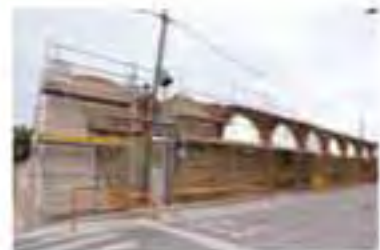
Obres de reparació de l'aqüeducte de l'horta d'en Caixa. PACO DALMAU
