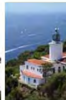
Vista aèria de l'edifici del far, dalt del penya-segat. PACO DALMAU
