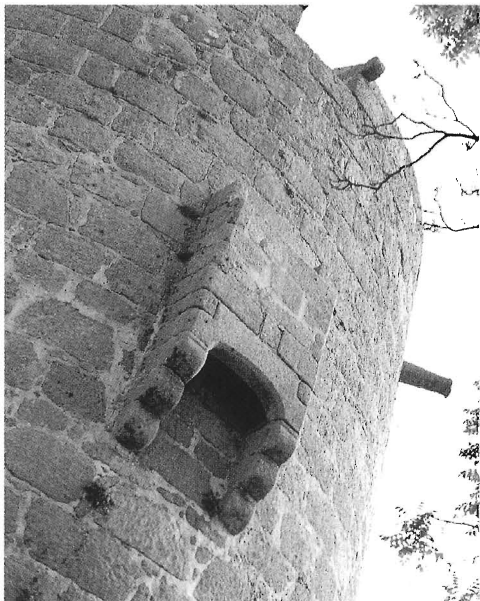
Matacà de la torre de Calella construït amb carreus de granit, a l'igual que els murs de la torre
