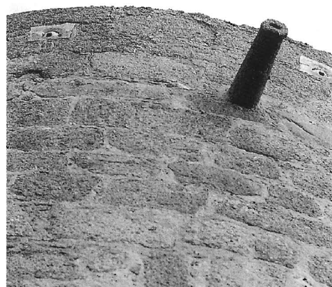
Gàrgola de la torre de Callela. Sobre la gàrgola podem veure-hi dues espitlleres giratòries
