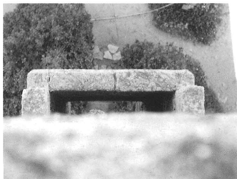
Matacà de la torre de Calella vist des del terrat
