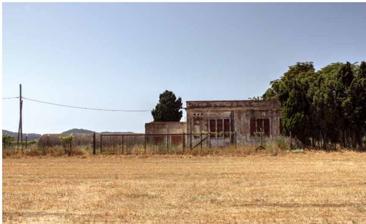
Estat actual de l'estació de bombeig Les Arenes.
