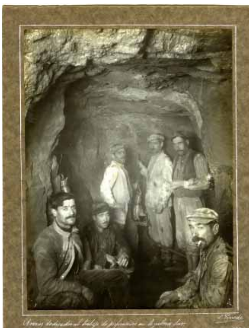
Treballadors de les obres de perforació del pou.
