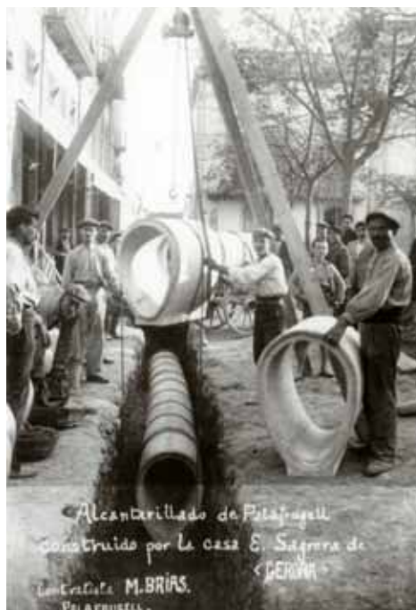
Clavegueram a l'altura de plaça Nova. Primer a l'esquerra, Jaume Casadevall Daussà, encarregat de les obres. Contractista, Miquel Brias Torrent, de Palafrugell.
