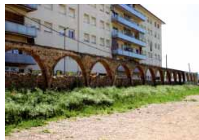
Estat actual de l'aqüeducte de l'Horta d'en Caixa després de les obres de reparació de 2013-2014.
