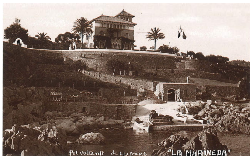
Els Vergés Barris foren dels primers a instal·lar-se a Llafranc. La Marineda fou construïda els primers anys del s. XX
