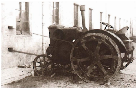
Tractor connectat a un embarrat a Manufacturas de Corcho Armstrong, S.A., cap al 1949
