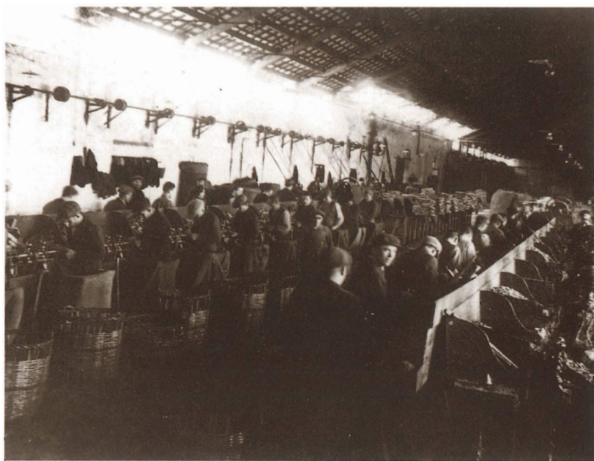
Màquines de barrina a can Mario
