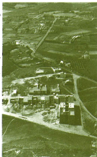
Obres de construcció a la Sauleda a finals dels anys seixanta. La Cooperativa de Viviendas San Martín va construir aquests blocs, que consten de planta baixa i quatre pisos. La Sauleda va acollir majoritàriament gent immigrada procedent del sud d'Espanya.
