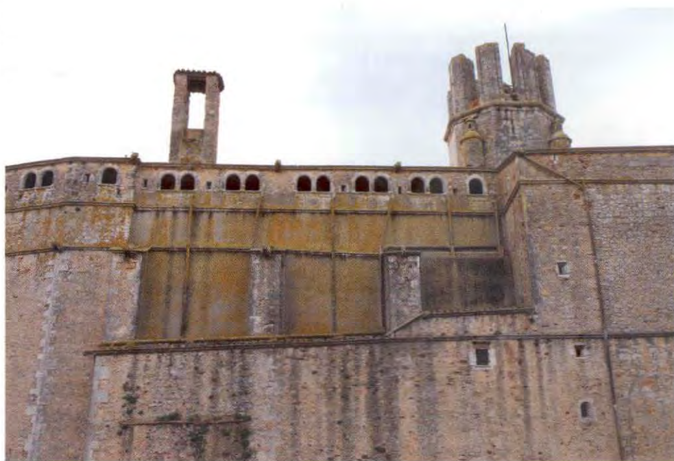
Fig. 11. Mur de tramuntana amb el campanar vell.
