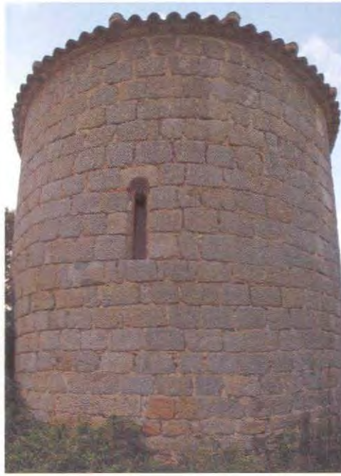
Fig. 109. Detall de la façana.
