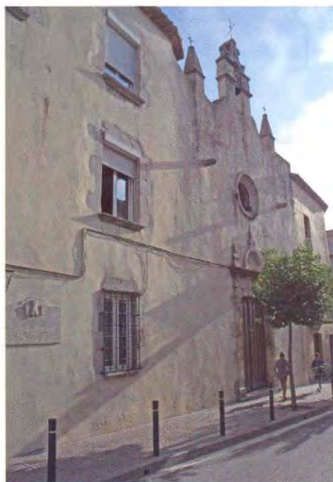
Fig. 99. Exterior de l'hospital.
