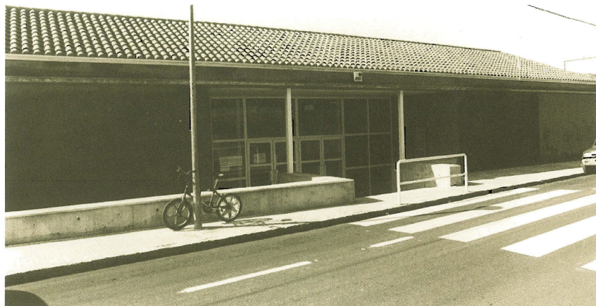
Estat actual de l'edifici del Col·legi Torres Jonama, 1993.
