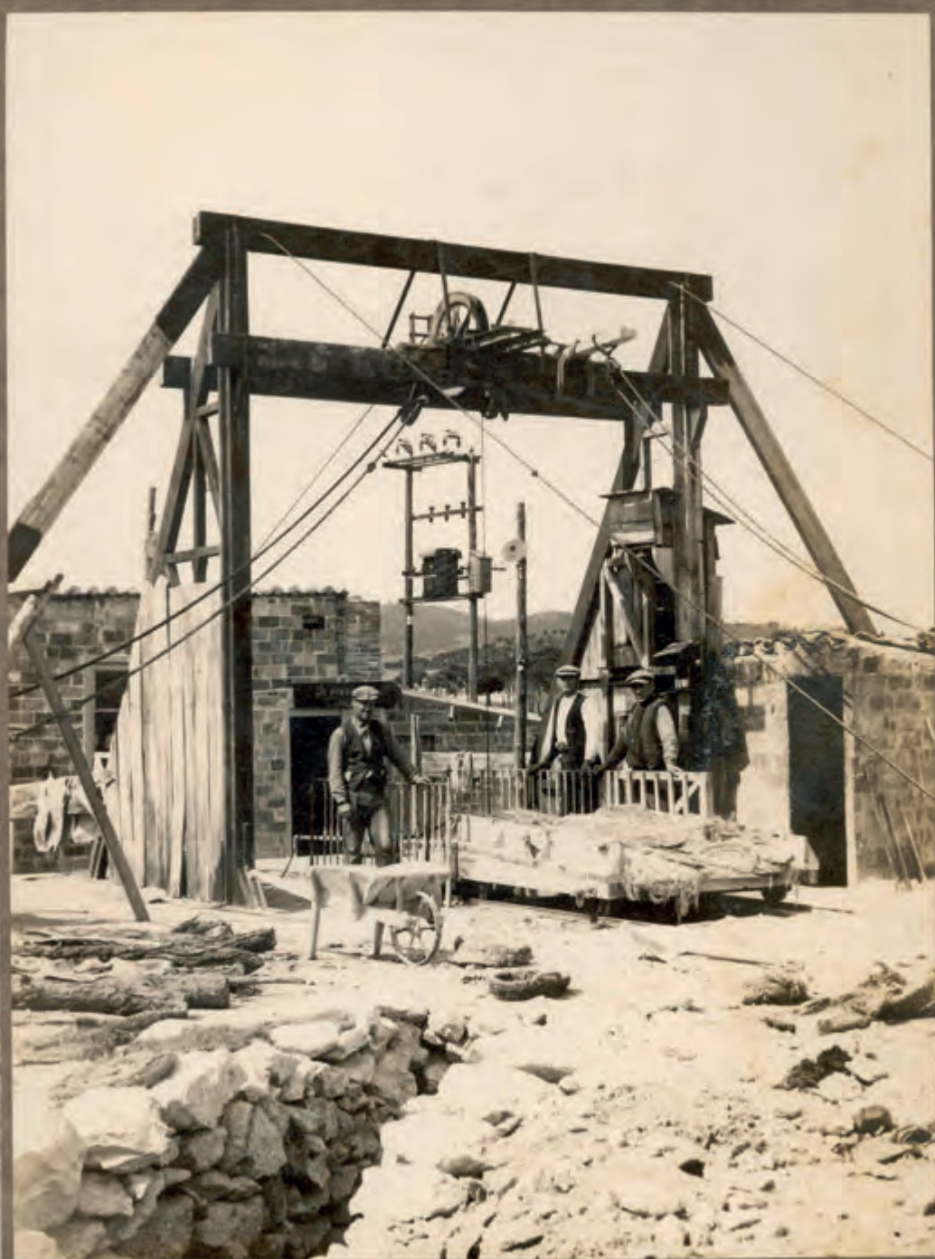
Vista parcial exterior del pozo que abastece de agua a Palafogell.
