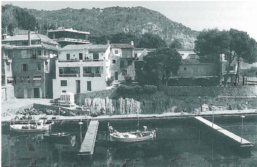
El port construït a la platja d'es Sot.
