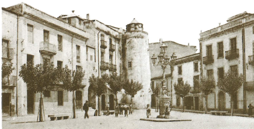
La font de plaça Nova es va instal·lar el 10 d'agost de 1882. S'alimentava d'un pou de 20 m de profunditat excavat l'any 1881
