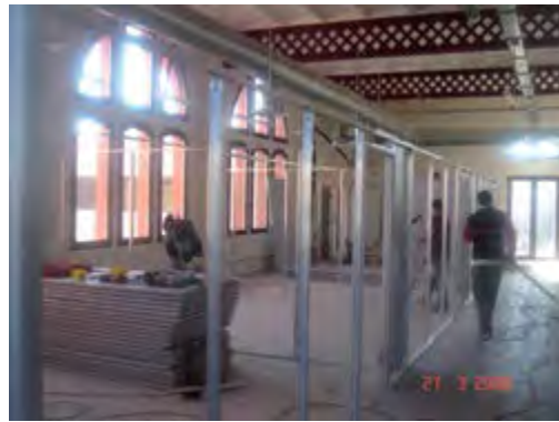
Preparació dels mòduls que es convertirien en aules, al pis superior. Foto Martí Pagès
