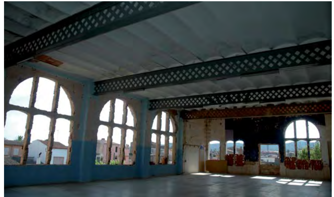
Sala de l'antic teatre, durant la remodelació. Foto Paco Dalmau
