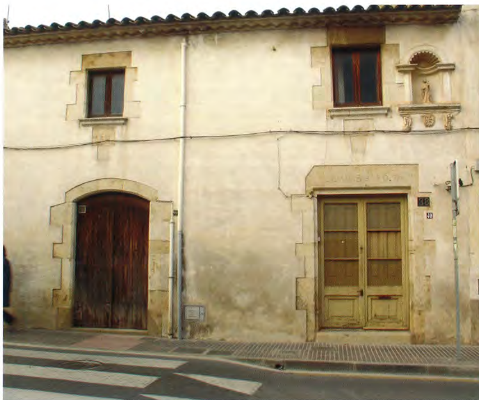
Casa del carrer de la Font on hi havia una sastreria.
