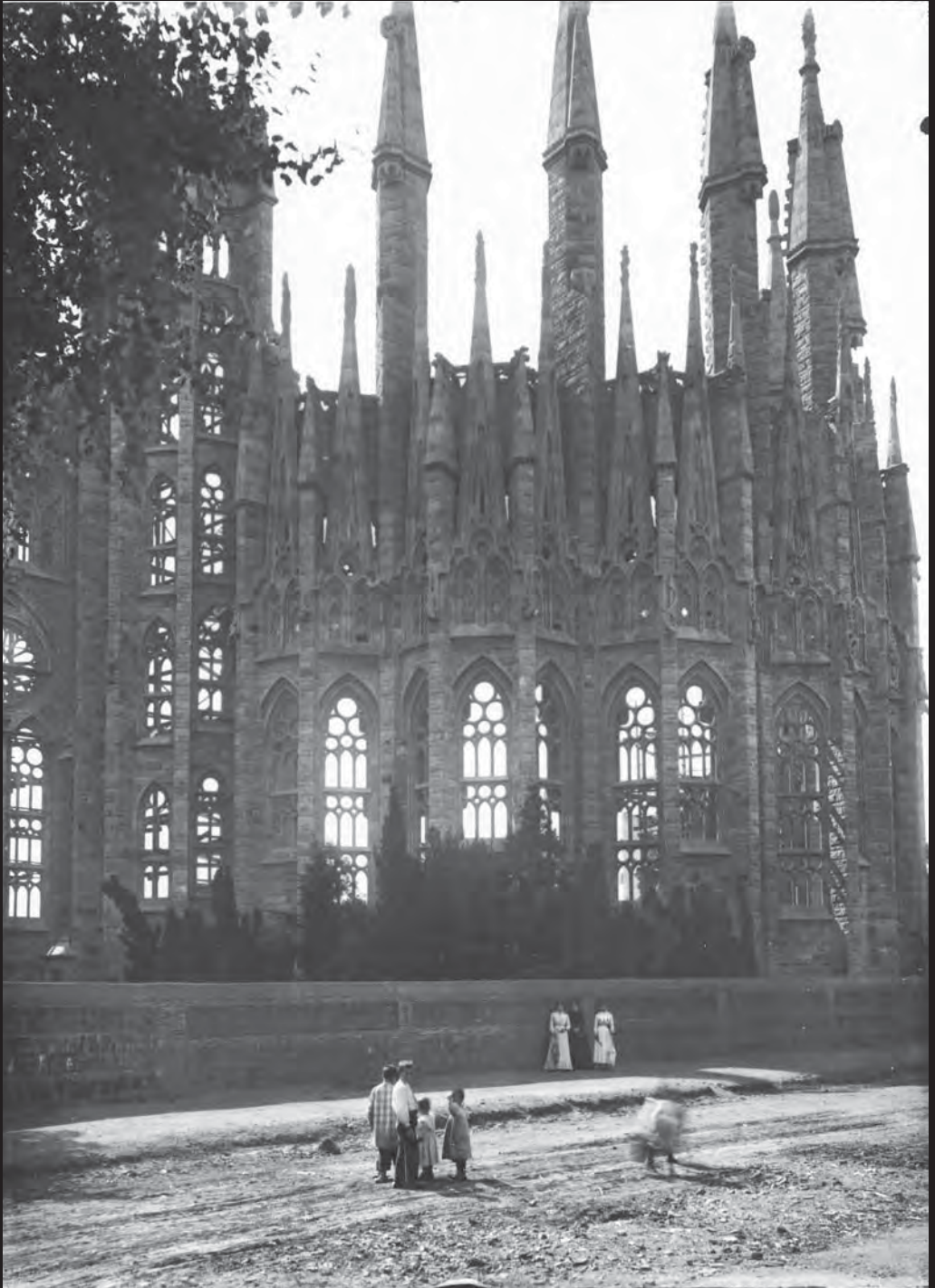
Absis del temple expiatori de la Sagrada Família, de l'arquitecte català Antoni Gaudí, en construcció. (1910-1915)
