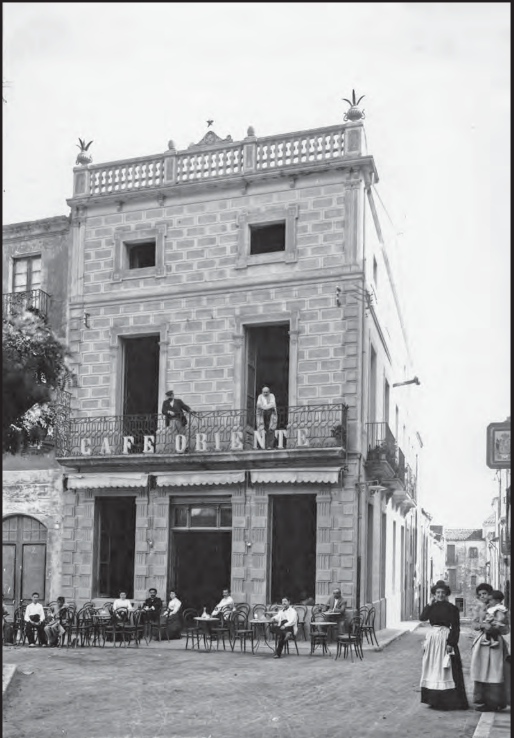
Façana del Café Oriente, a la Plaça Nova de Palafrugell cantonada amb el carrer de Sant Martí. Posteriorment, va ser l'Hotel Oriente, propietat d'August Farràs.
