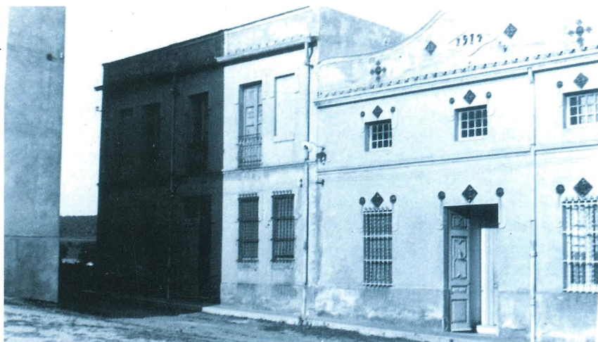
Una fotografia dels anys quaranta de la casa que acabaria essent la Pensión Plancton, al carrer de Codina; la paret de l'esquerra es de l'església
