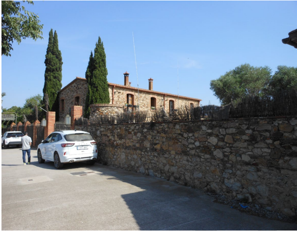
Front de la finca a la C-31. Façana de l'edificació que s'havia destinat a local de restauració.
