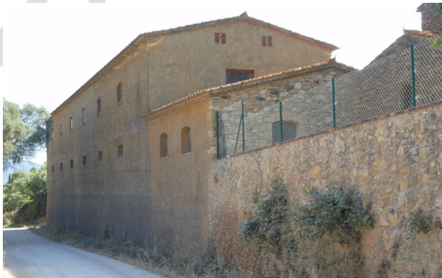
Front Oest de la finca. Edifici destinat a museu
