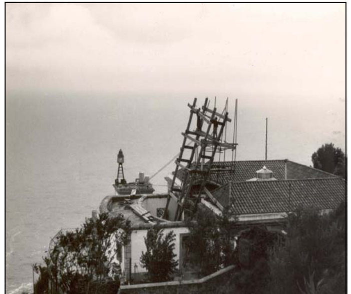
Bastida utilitzada per a la reforma de la torre del far i els treballs de construcció d'una nova llanterna aeromàritima l'any 1963. Col·lecció Rosina Llozano, AMP.
